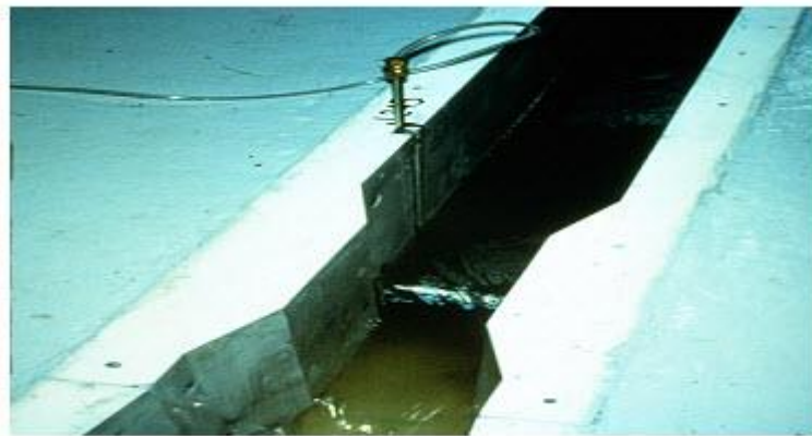
Fig. 19.8. Parshall flume.
