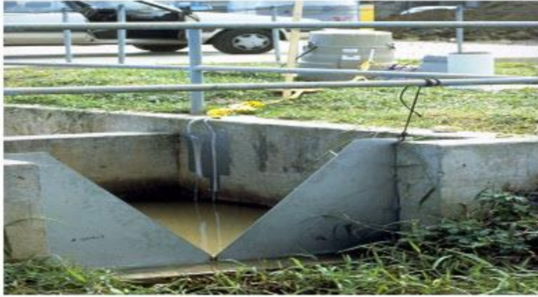
Fig. 19.11. V-Notch Weir.
