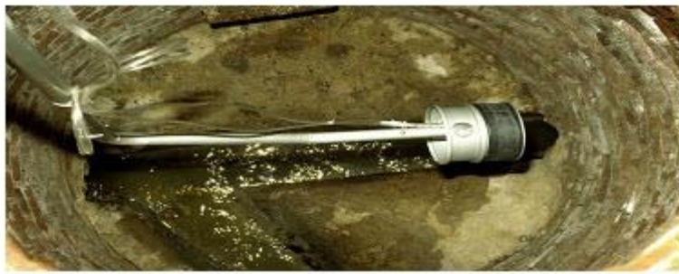
Fig. 19.12. Flow Metering Insert (Weir).
